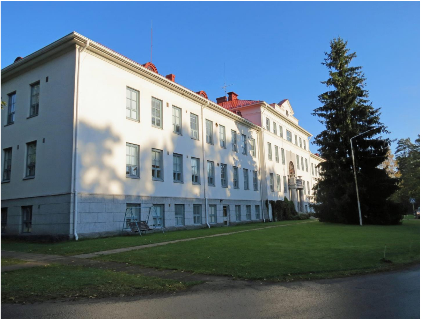
Moision sairaalan päärakennus. (Kuva Raimo Kontinen)
